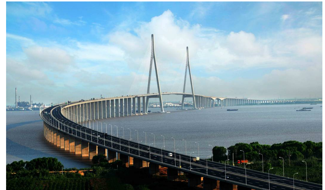
图 4.1 苏通长江公路大桥
